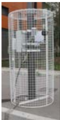
Station rue de la Buire (Lyon) / Véolia
